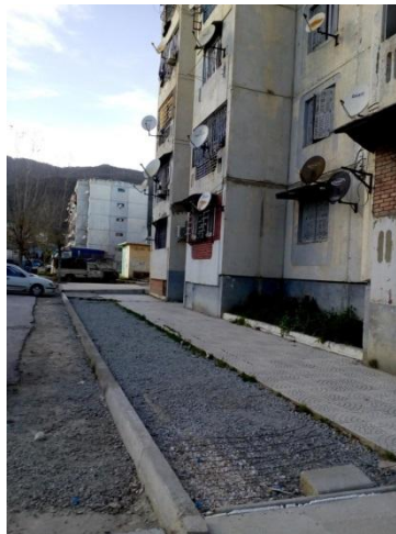
Photo 9 : De la rénovation à la création des trottoirs et voies piétonnes (auteur, 2018)
